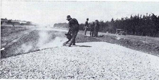
Hand pouring bitumen, 1928.
