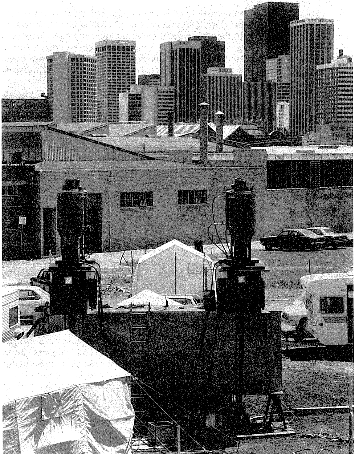
Fig. 16. Static pile load test
